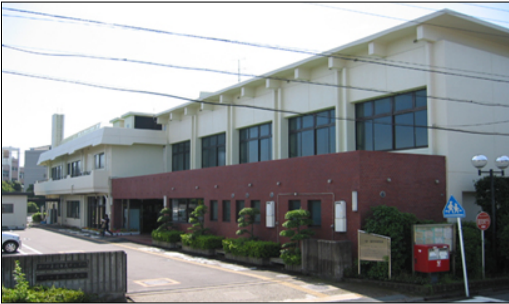
[善行市民センター外観写真]
