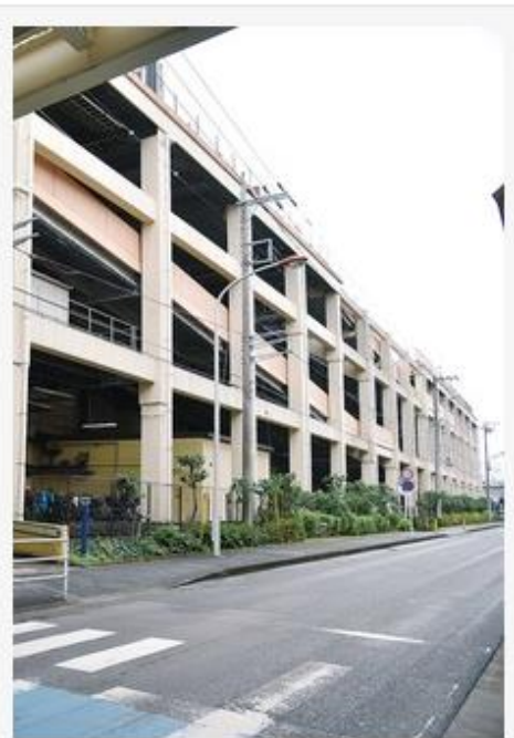
湘南モールフィル立体駐車場
