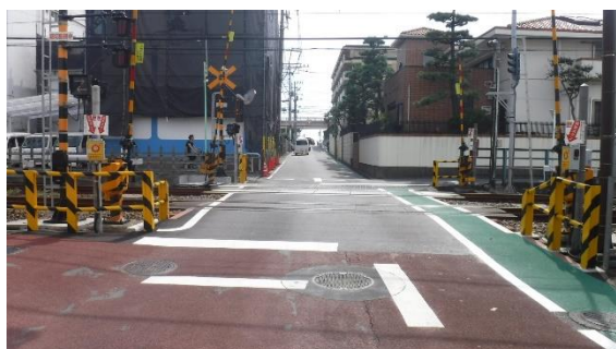
鵜沼海岸10号踏切の改良 （道路整備課）
