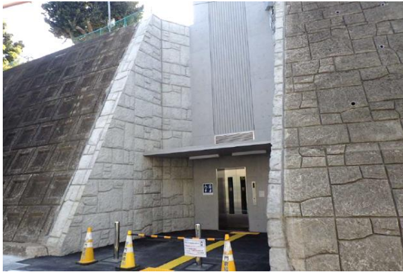
県立スポーツセンター西側階段付近に エレベーターを設置
